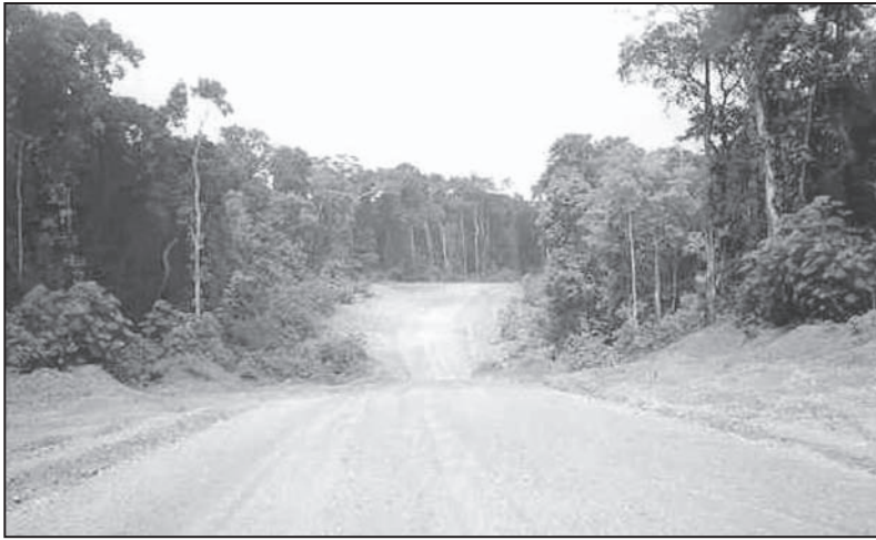
Route pour l'exploitation forestière, sud-est du Liberia,
