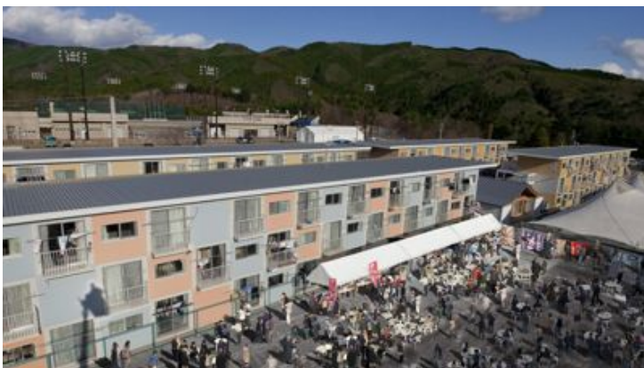
Ban architect designed temporary housing 坂建築事務所によるコンテナを利用した仮設住宅 (宮城県-女川市)
